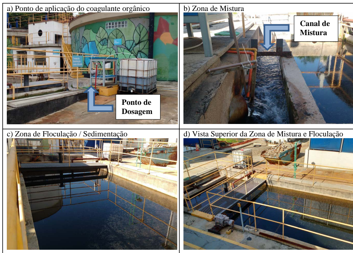
Figura 4: Tanque de Desinfecção Utilizado como Tanque de Aplicação do Coagulante, Floculação e Sedimentação dos Flocos.
